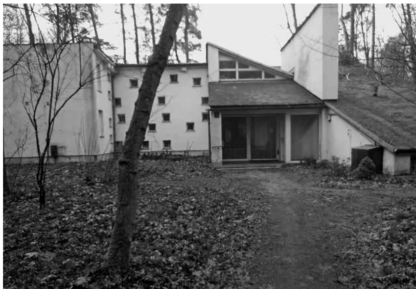
Dom nad Łączką od strony północnej
