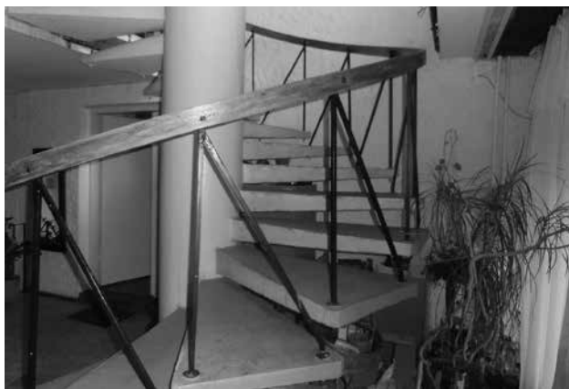
Schody z parteru na I piętro
